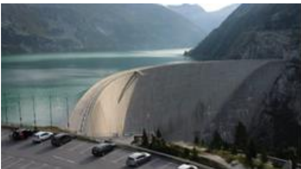
Figure 14. Kölnbrein Dam (Austria) [31]
